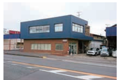
改装後の店舗外観
