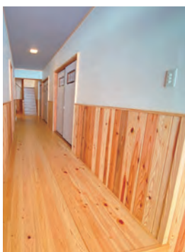
床板を替え、新たに腰板も貼った廊下
