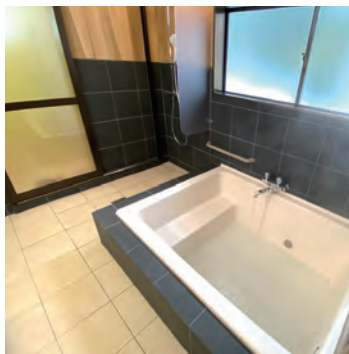
改装した浴室
