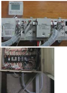
多回路エネルギーモニター施工の様子
