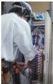
多回路エネルギーモニター施工の様子
